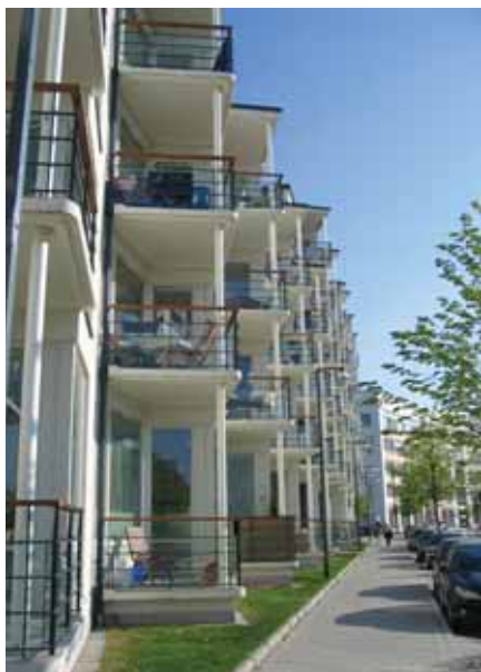
Hammarby sjöstad. Exempel på snedvinklade balkonger som möjliggör bättre utblickar och ger lätthet åt byggnaden.
