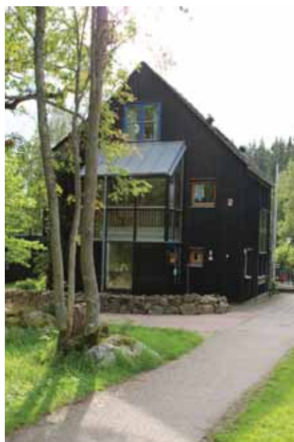
Hestra parkstad, Borås/ Niels Torp Arkitektkontor. Inre gårdsrum där mur markerar tomtgräns samt exempel på hur byggnad kan placeras för att markera kvartershörn
