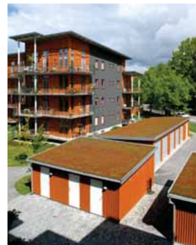
Kv. Ulla, Örebro. Exempel på sedumtak på komplementbyggnader.
